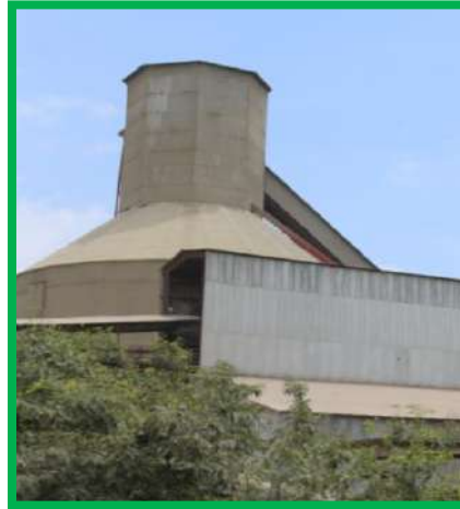
Clinker Silo: 45000 Tonne
