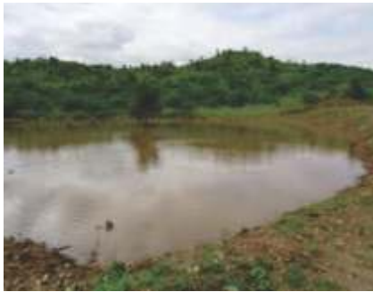
मिनी परकोलेशन टैंक और एनीकट का निर्माण
